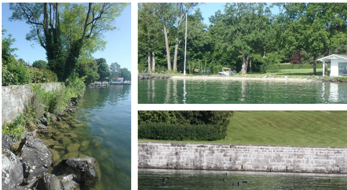
Figure 4: Différents faciès de rivage présents sur la commune : grève (haut), mur avec végétation et enrochements (gauche) et mur jointoyé sans enrochements (bas).
